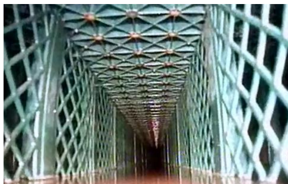
Figure 2 : Inspection après curages (bassin propre)
