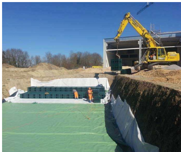
Figure 4 : Mise en place du géotextile intérieur et pose des modules Rigofill®
