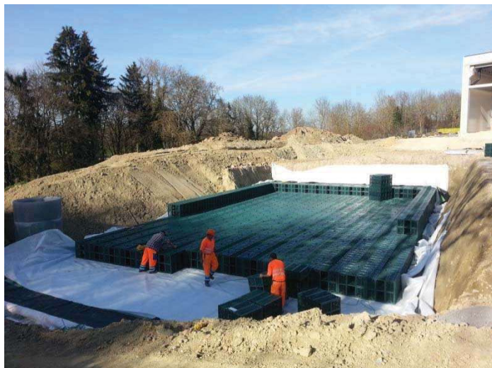
Figure 5 : Installation des modules Rigofill® sur deux étages
