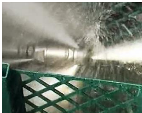
Figure 4 : Hydrocurage à l'intérieur des tunnels d'inspection
