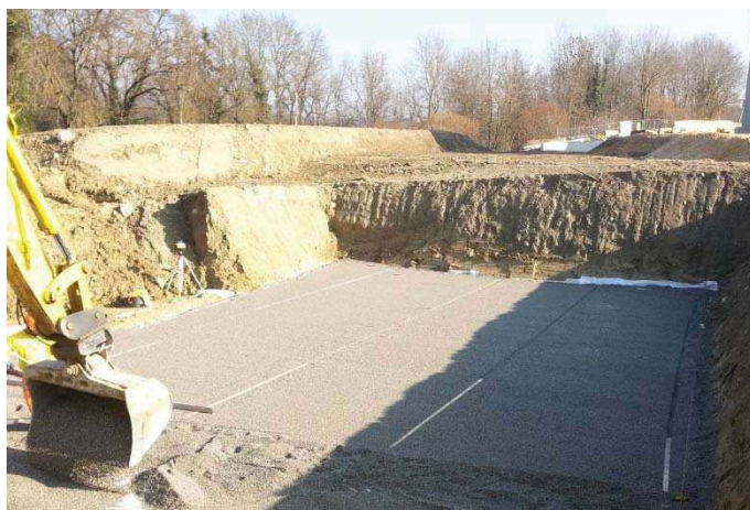
Figure 1 : Réalisation du lit de pose en 4 - 8
