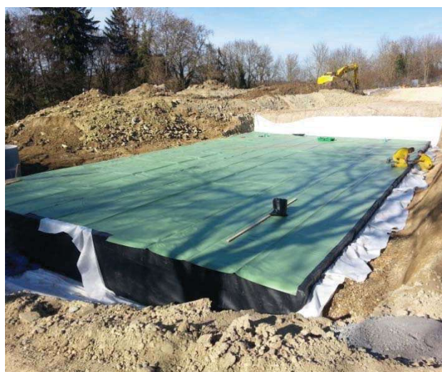
Figure 8 : Réalisation des soudures afin de garantir l'étanchéité totale (en option)
