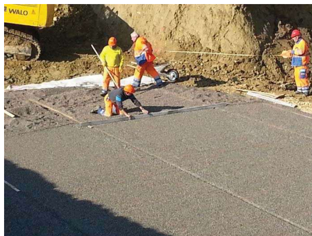
Figure 2 : Mise à niveau du lit de pose
