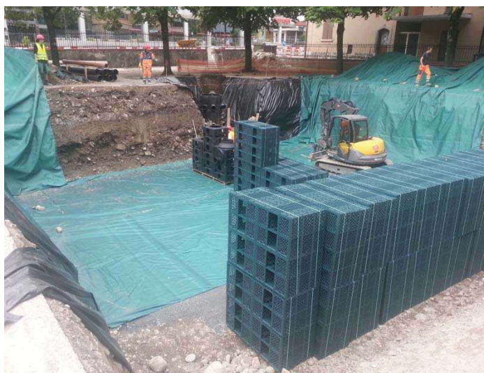
Figure 11 : Mise en place d'un géotextile pour l'infiltration
