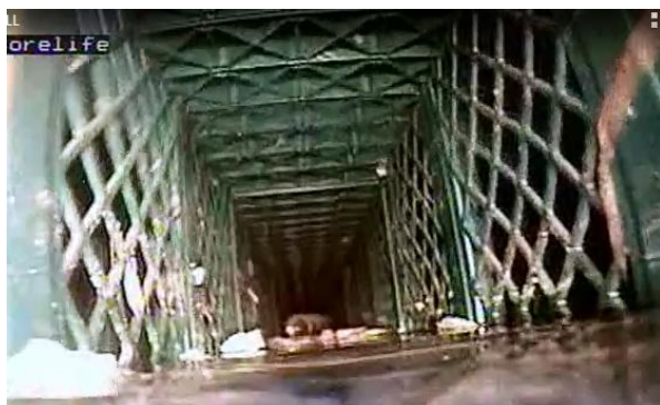
Figure 1 : Inspection avant curage des modules Rigofill® comprenant des macrodéchets importants (bassin sale)
