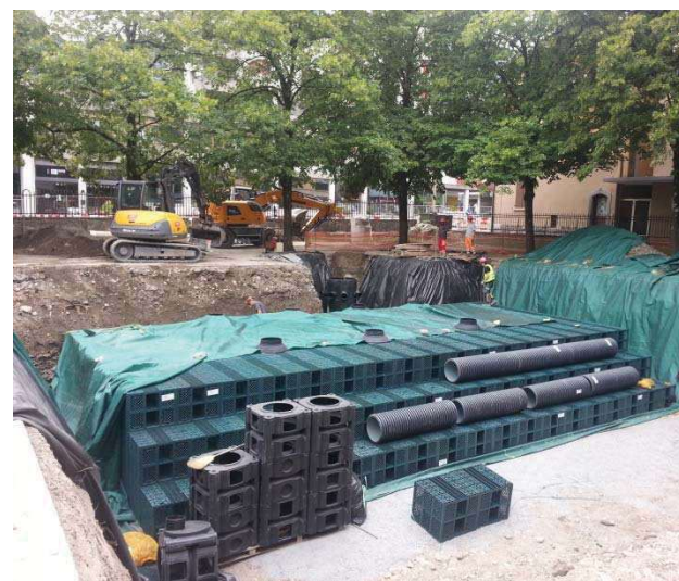
Figure 12 : Mise en place des modules Rigofill® et des chambres Quadro-Control pour réaliser le bassin d'infiltration
