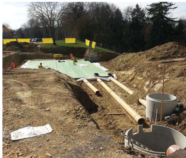
Figure 6 : Connexion du réseau pluvial au bassin de rétention
