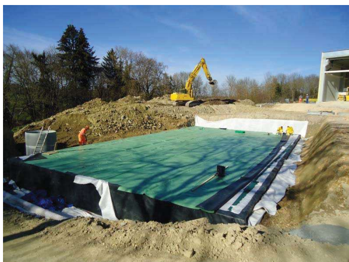
Figure 7 : Mise en place de la géomembrane supérieure
