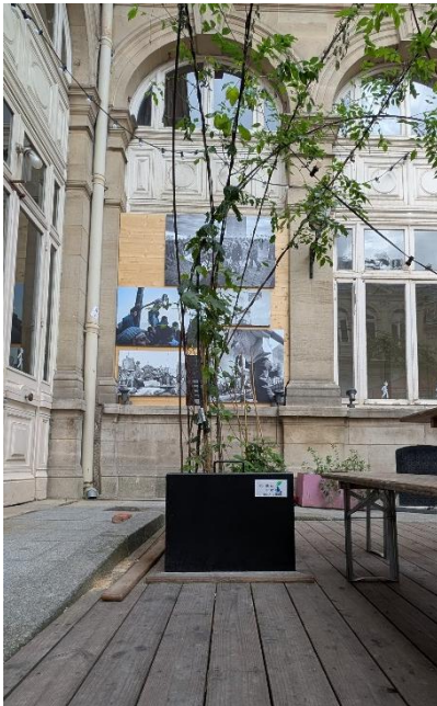
Exemples de Jardin de Pluie Urbain hors-sol (g. structure acier revêtu, d. structure acier revêtu avec bardage bois)
