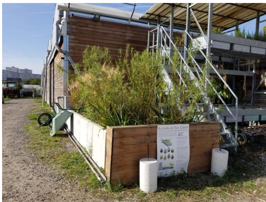
Exemples de Jardin de Pluie Urbain en pied de bâtiment – récupération des EP de toiture
