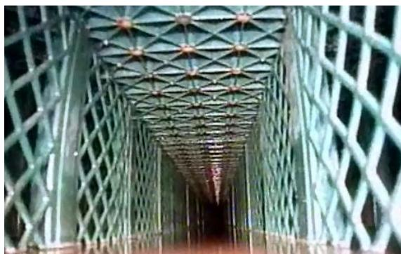
**Figure 2 :** Inspection après curages (bassin propre)
