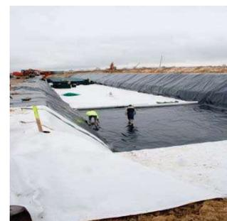
Les dimensions du géotextile intérieur correspondent à la longueur et largeur du bassin augmentées de 50 cm de part et d'autre.
