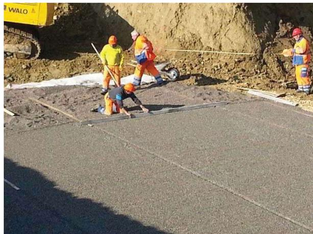
**Figure 2** : Mise à niveau du lit de pose
