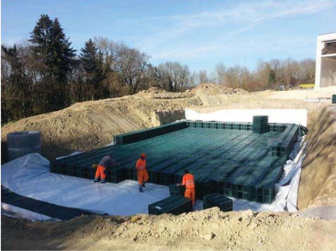
**Figure 5 :** Installation des modules Rigofill® sur deux étages
