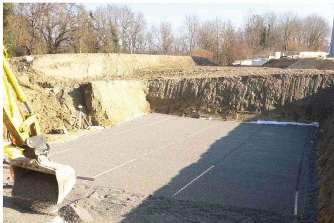
**Figure 1** : Réalisation du lit de pose en 4 - 8
