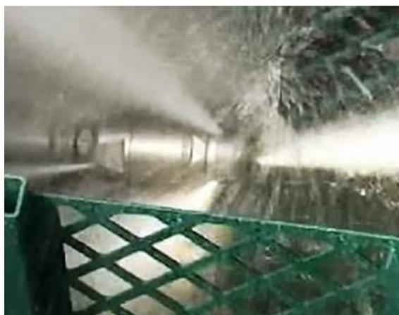
**Figure 4 :** Hydrocurage à l'intérieur des tunnels d'inspection
