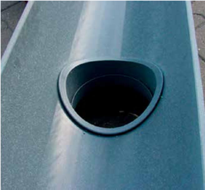
Vue intérieure après hydrocurage
