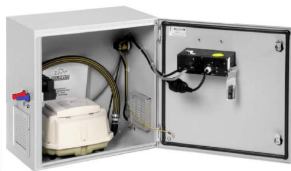
Armoire interne métallique
