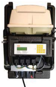
Illustration 3: vue intérieure de l'armoire de pilotage en EPP
