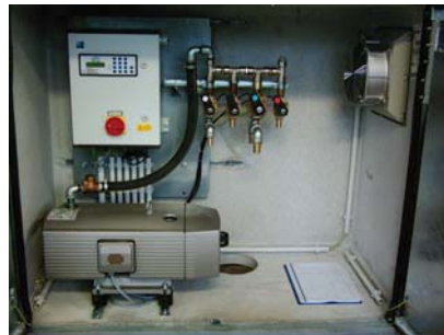
Illustration 4: vue intérieure d'une armoire en béton à double porte
