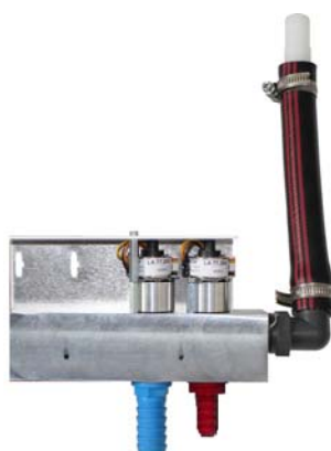
Rampe de vannes (face arrière)
