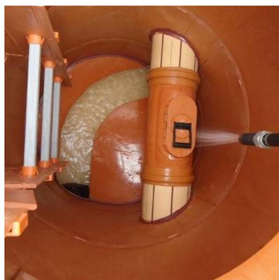
**Figura 4** : Controllo della tenuta stagna della camera
