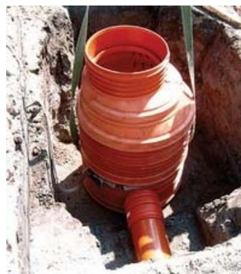
**Figura 5** : Posa di una camera da interrare
