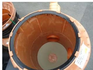
**Bild 6 :** Gummidichtung auf Teleskop-Konus einlegen
