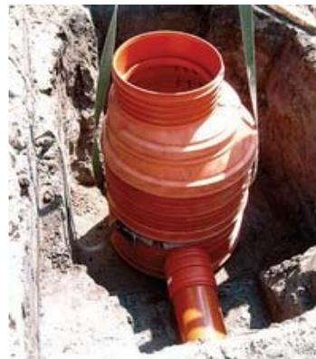
**Bild 5** : Versetzen von einem Schacht zum Erdverlegen
