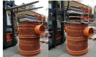
**Bild 5 :** Schachtrohr wird aufgesetzt
