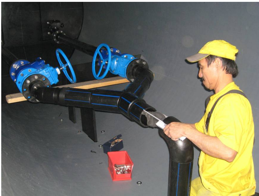
Montage des Druckrohres aus PE
