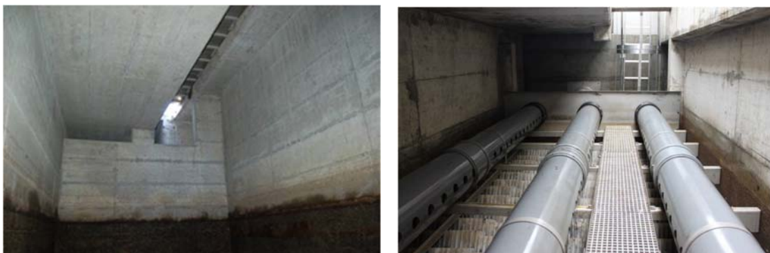
Figura 1 : Prima e dopo la rimessa a nuovo dei bacini con decantatori lamellari
