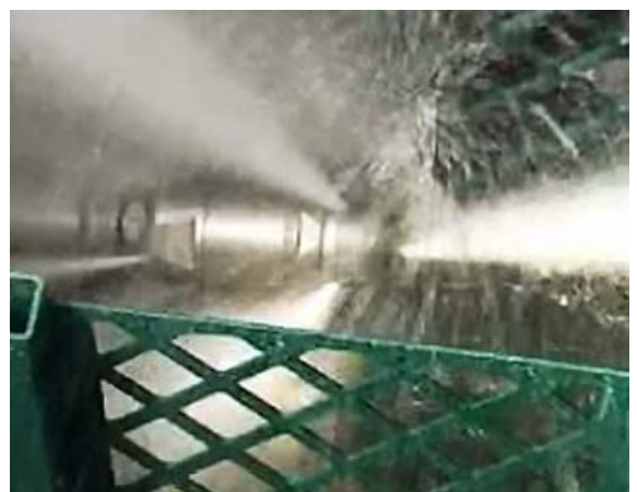
Figura 4 : Idropulitura all'interno dei tunnel d'ispezione
