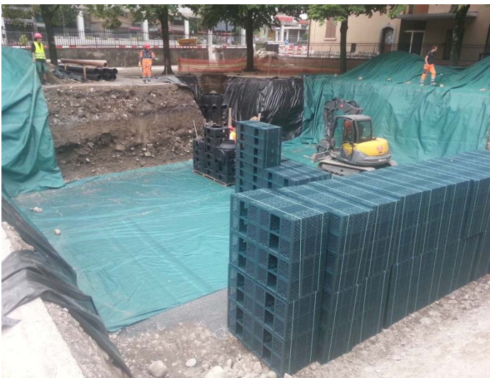
Figura 11 : Posa di un geotessile per l'infiltrazione
