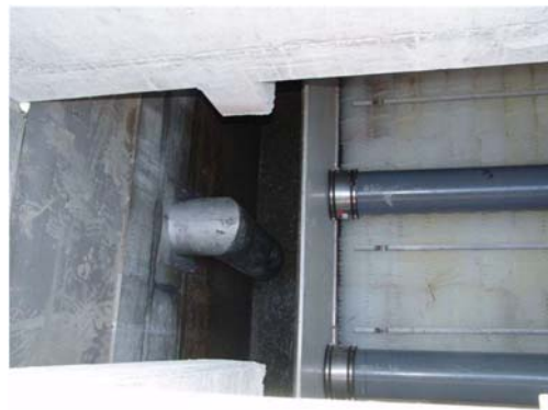
Figura 8 : Scivolo di ripresa delle acque decantate
