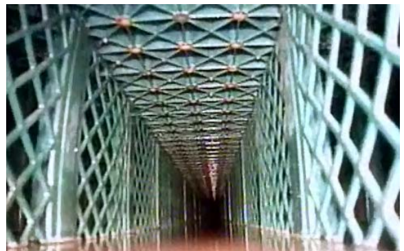
Figura 2 : Ispezione dopo la pulitura (bacino pulito)
