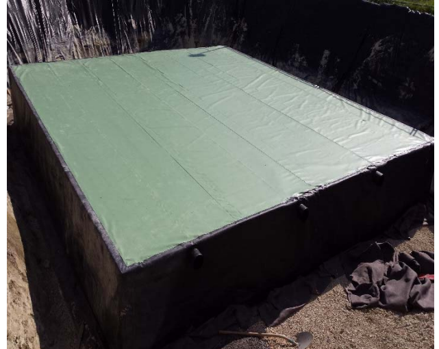
Figura 10 : Bacino totalmente stagno
