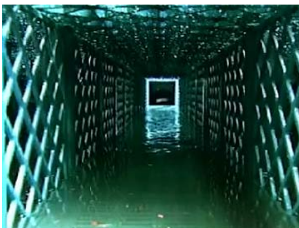
Figura 3 : Ispezione di un bacino tipo Rigofill© dopo idropulitura attraverso il passaggio di pulitura
