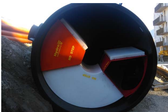
Figure 1 : First Defense®, Ø 1'800 mm flusso di trattamento 90 l/s
