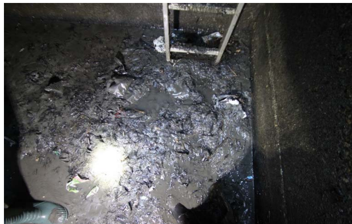
Figura 2 : Agenti inquinanti intrappolati nella camera di tranquillizzazione del bacino Les Sablons
