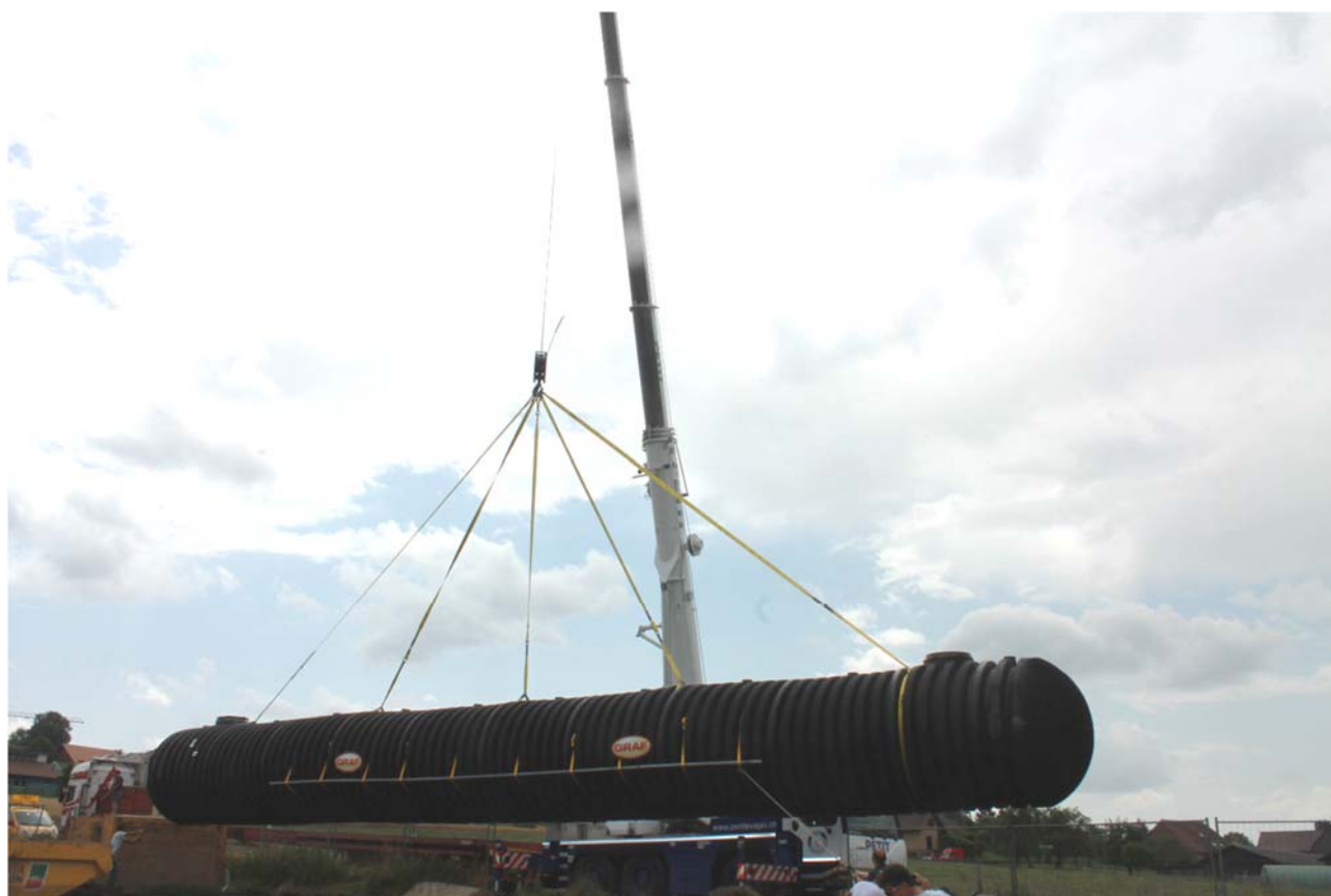
Immagine 2: Serbatoio da 102.000 litri
