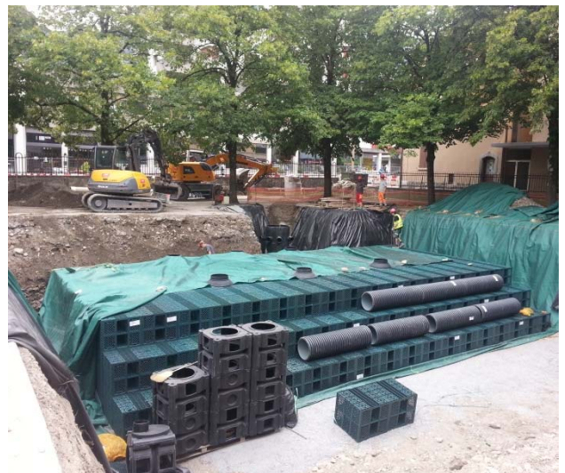
Figura 12 : Posa dei moduli Rigofill® e delle camere Quadro-control® per realizzare il bacino d'infiltrazione
