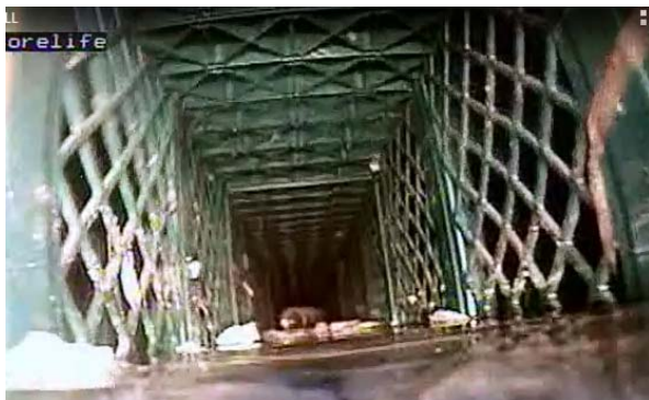
Figura 1 : Ispezione prima della pulitura dei moduli Rigofill© con macrorifiuti importanti (bacino sporco)
