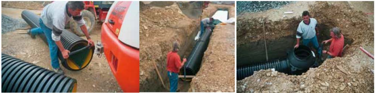
Figura 1: Svolgimento delle fasi di posa
