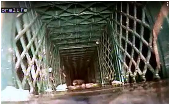
Abb. 1 : Inspektion vor Reinigung der Rigofill®-Blöcke verschmutzt
