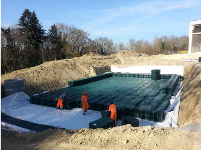
Abb. 5 : Einbau der Rigofill®-Blöcke in zwei Lagen
