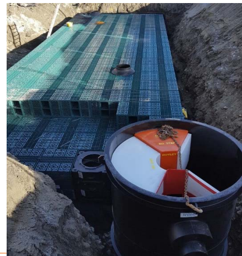
Abb. 2 : First Defense® vor einem Rigofill®-System
