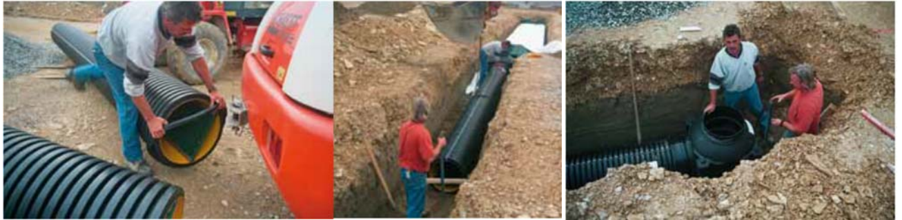
Abb. 1: Ablauf der Installationsetappen
