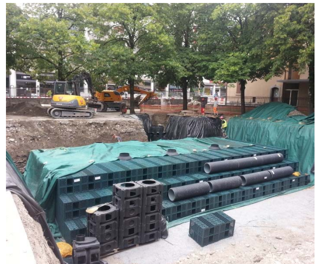
Abb. 12 : Einbau der Rigofill®-Blöcke und Quadrocontrol®-Schächte zur Realisierung eines Versickerungsbeckens
