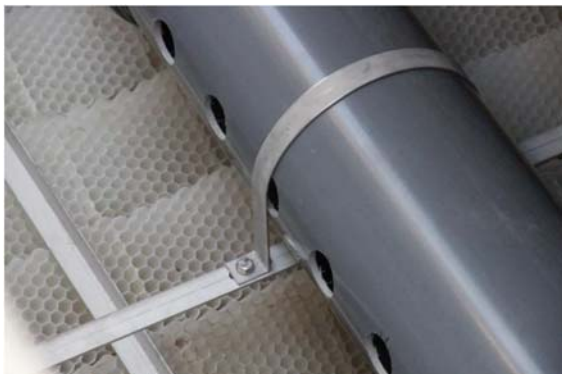
Abb. 7 : Rohr zur Ableitung des dekantierten Wassers
