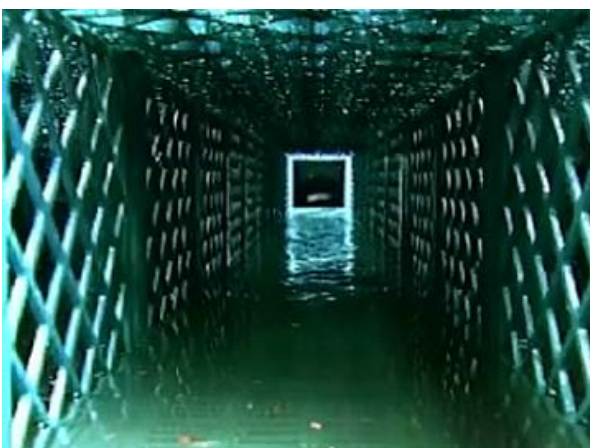
Abb. 3 : Inspektion eines Beckens des Rigofill-Typs nach der Reinigung im Tunnel
