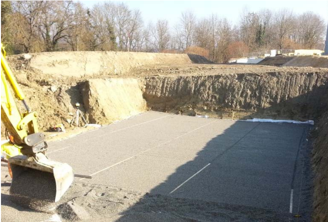
Abb. 1 : Ausführung der Grabensohle
