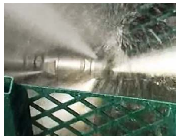
Abb. 4 : Kanalreinigung im Inspektionstunnel
