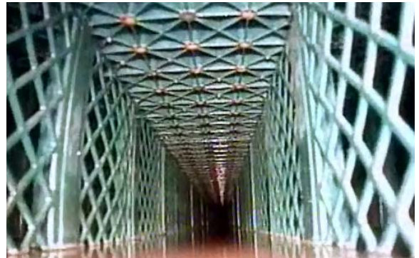
Abb. 2 : Inspektion nach Reinigung sauber
