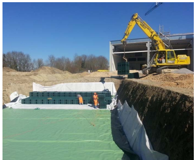
Abb. 4 : Auslegen des inneren Vlieses und Verlegung der Rigofill® Blöcke
