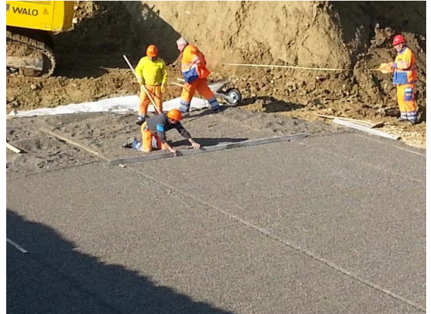
Abb. 2 : Einbringen der Ausgleichsschicht
