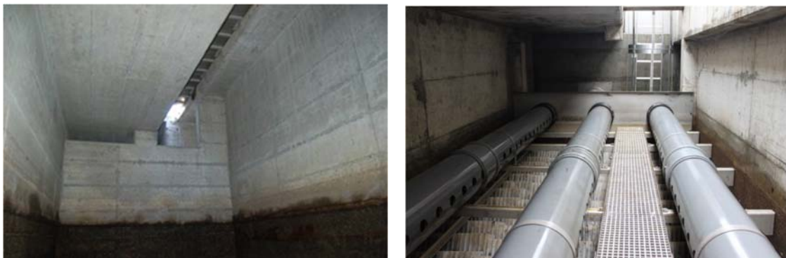
Abbildung 1 : Vor und nach Ausbau der Becken mit Lamellenabscheidern
