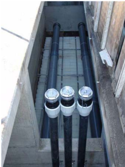
Abb. 5 : Ansicht des gesamten oberen Teils der Lamellenblöcke
