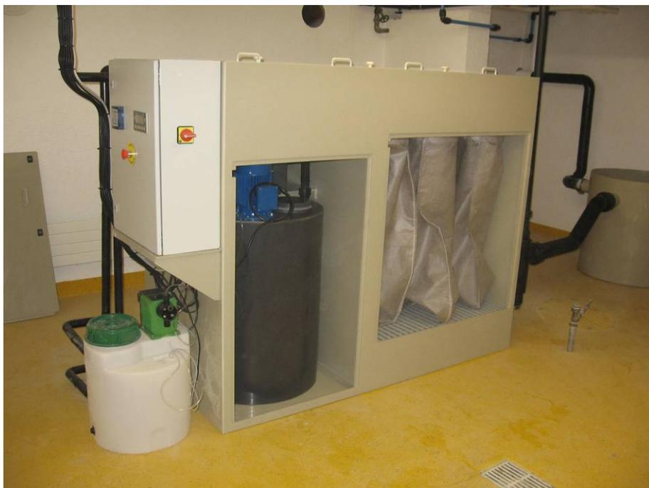
**Serbatoi di stoccaggio, reattore di coagulazione/flocculazione, reattore per il controllo del pH, decantatore lamellare (processo Decofloc®)**
