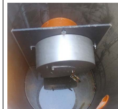
Montage dans une chambre en plastique
