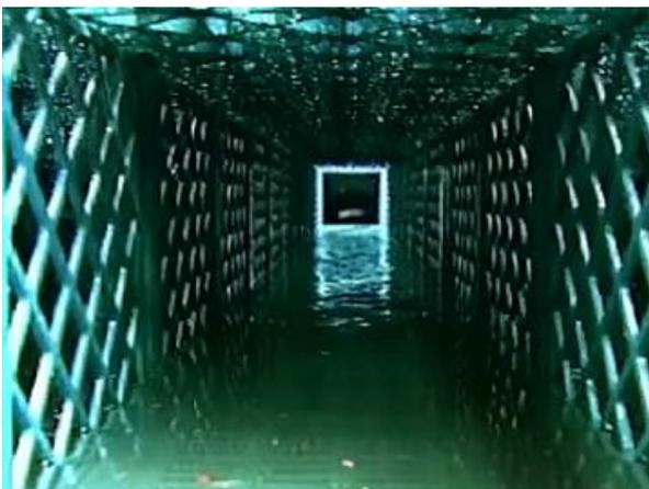
**Figura 3 :** Ispezione di un bacino tipo Rigofill© dopo idropulitura attraverso il passaggio di pulitura
