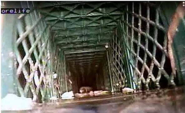
**Abb. 1 :** Inspektion vor Reinigung der Rigofill®-Blöcke verschmutzt
