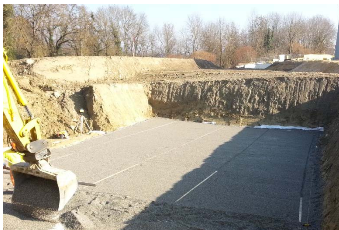
Figure 1 : Réalisation du lit de pose
