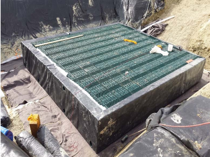
Figure 9 : Première étape de soudure pour réaliser l'étanchéité totale
