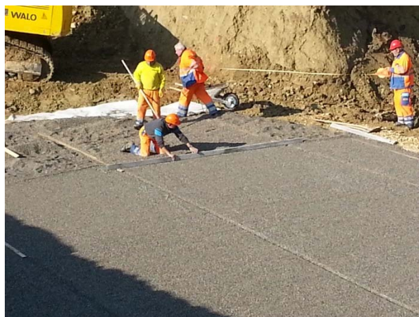
Figure 2 : Mise à niveau du lit de pose
