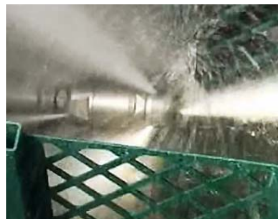
Figure 4 : Hydrocurage à l'intérieur des tunnels d'inspection
