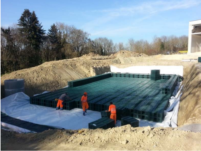
Figure 5 : Installation des modules Rigofill® sur deux étages
