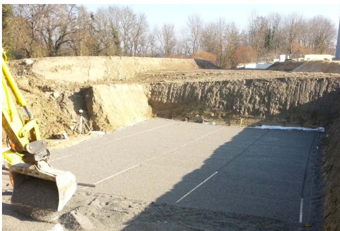
Figura 1 : Realizzazione del letto di posa
