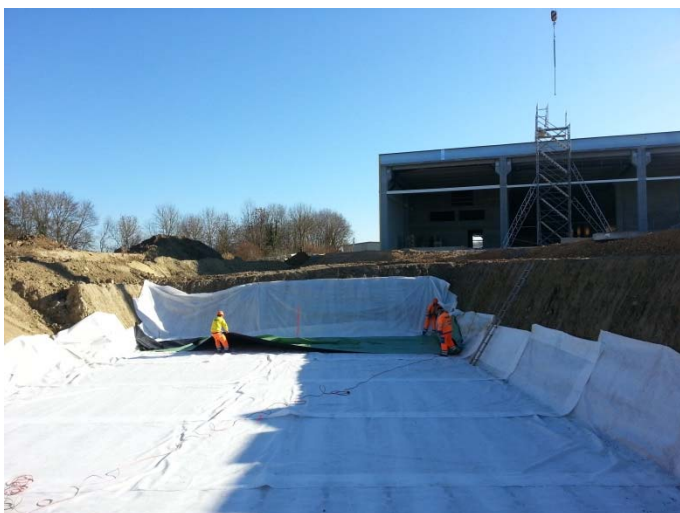
Figura 3 : Posa del geotessile esterno e della geomembrana
