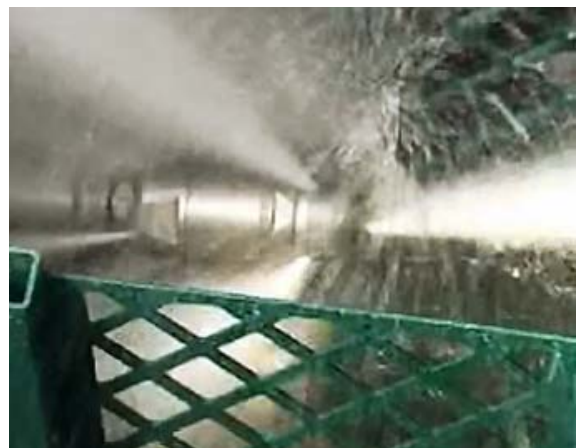
Figura 4 : Idropulitura all'interno dei tunnel d'ispezione
