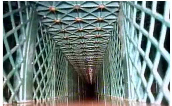
Figura 2 : Ispezione dopo la pulitura (bacino pulito)
