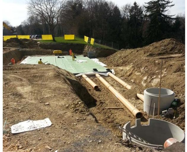
**Abb. 6 :** Anschluss der Regenwasserleitung an das Retentionsbecken
