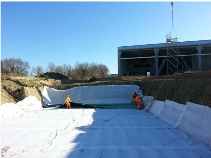
**Abb. 3 :** Verlegen des äusseren Vlieses und der Folie
