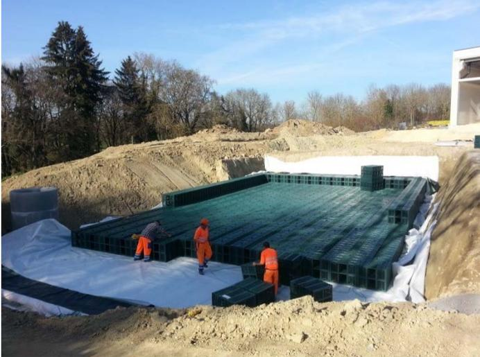
**Abb. 5 :** Einbau der Rigofill®-Blöcke in zwei Lagen
