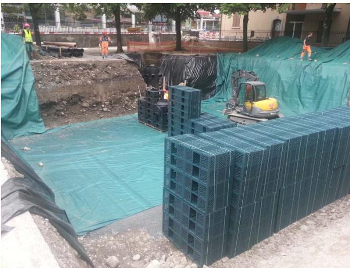
**Abb. 11** : Verlegen einer Vlieses für die Versickerung
