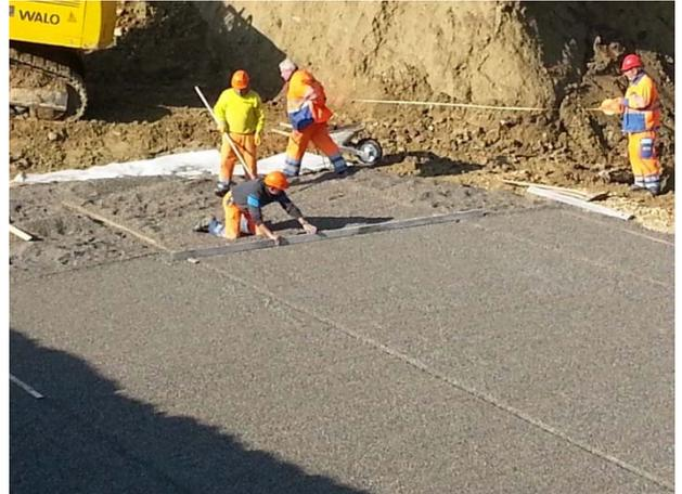
**Abb. 2 :** Einbringen der Ausgleichsschicht
