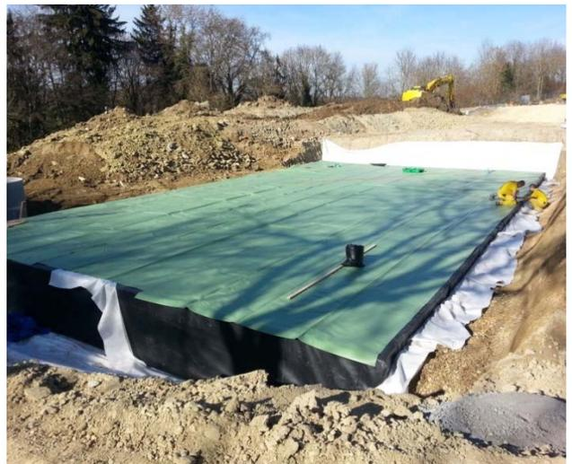
**Abb. 8 :** Verschweissen der Stösse um die Dichtheit zu gewährleisten (optional)
