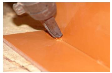
2. Das Schweissen erfolgt unter Verwendung einer entsprechenden Spitze. Das dazugegebene Material hat die Form dreieckiger Ringe. Die vom Gerät erzeugte Luft mit einer Temperatur von über 300°C erhitzt gleichzeitig die untere Fläche des Rings und die obere Fläche des Trägers.
