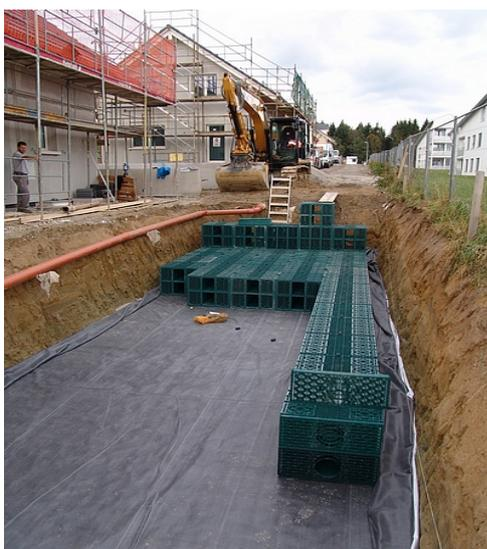
Posa dei moduli sulla geomembrana protetta dal geotessile
