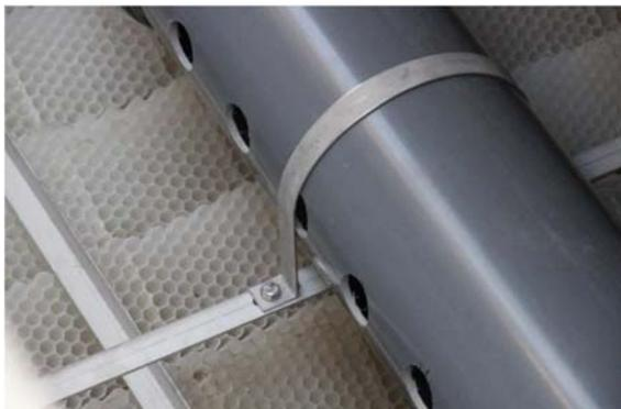
**Abb. 7 :** Rohr zur Ableitung des dekantierten Wassers
