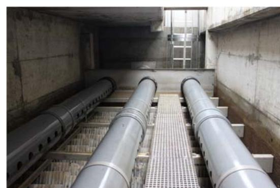
**Figura 1 :** Prima e dopo la rimessa a nuovo dei bacini con decantatori lamellari
