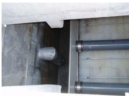
**Figura 8 :** Scivolo di ripresa delle acque decantate
