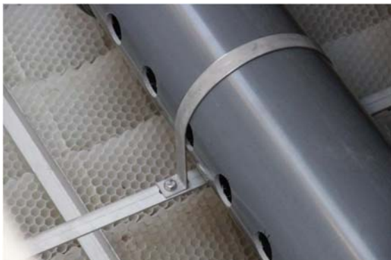
Figure 7 : Goulotte de reprise des eaux décantées
