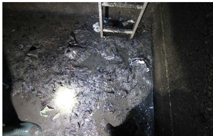
Abbildung 2 : Abgefangene Verunreinigungsstoffe in der Beruhigungskammer des Beckens les Sablons
