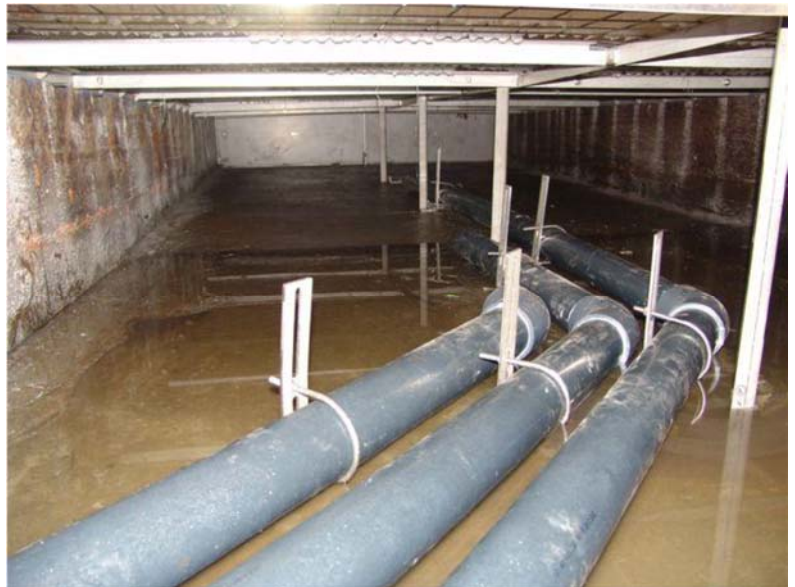
Abb. 6 : Ansicht des unteren Teils der Lamellenblöcke
