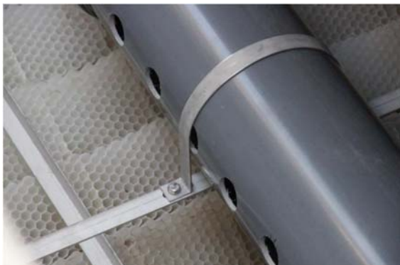
Abb. 7 : Rohr zur Ableitung des dekantierten Wassers
