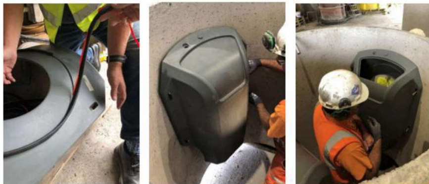
Figure 1 : Intégration d'un kit First Defense® dans un ouvrage en béton
