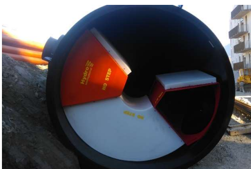
Figure 2 : Chambre complète en PE-HD, First Defense® Ø 1800 mm, débit de traitement 90 l/s
