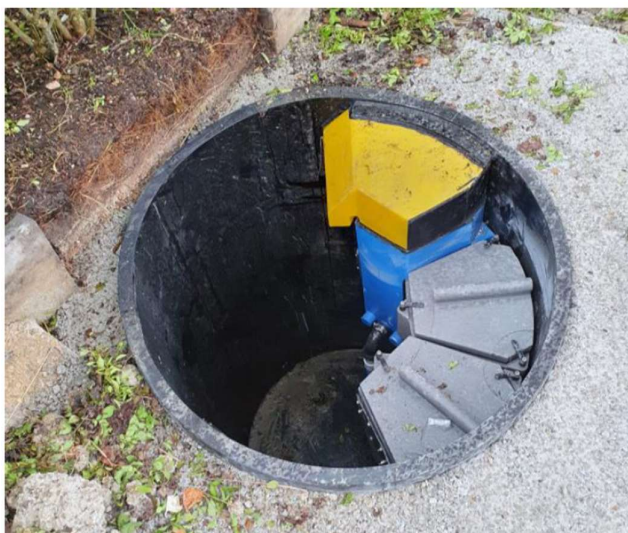
Figure 4 : Système Up-FLO® avec intégration du filtre CPZ®
