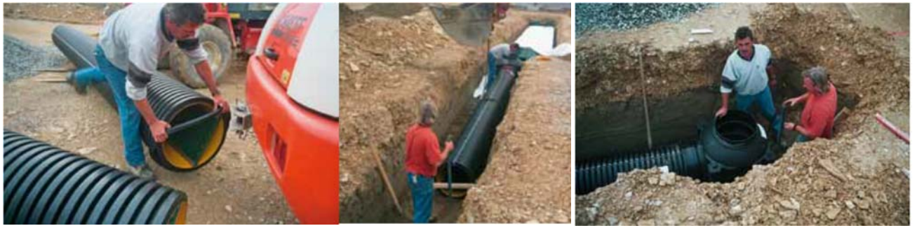
Figure 1: Déroulement des étapes de pose
