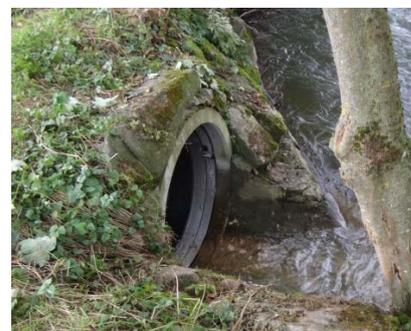
Messa in opera di una clappa anti-ritorno Wastop® Ø 1200 in un condotto esistente in calcestruzzo per evitare il carico della rete durante l'innalzamento delle acque del fiume.
