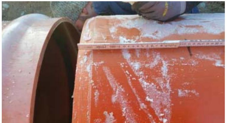
3. Applicare sapone o vaselina solo sul labbro della guarnizione e sull'estremità del tubo da incastrare (Non usare mai grasso, perché deteriora la guarnizione)
