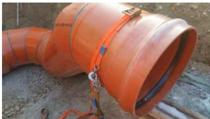
7. Passare un 3° e un 4° SpanSet nei primi due, in ogni lato del tubo e lungo gli assi.
