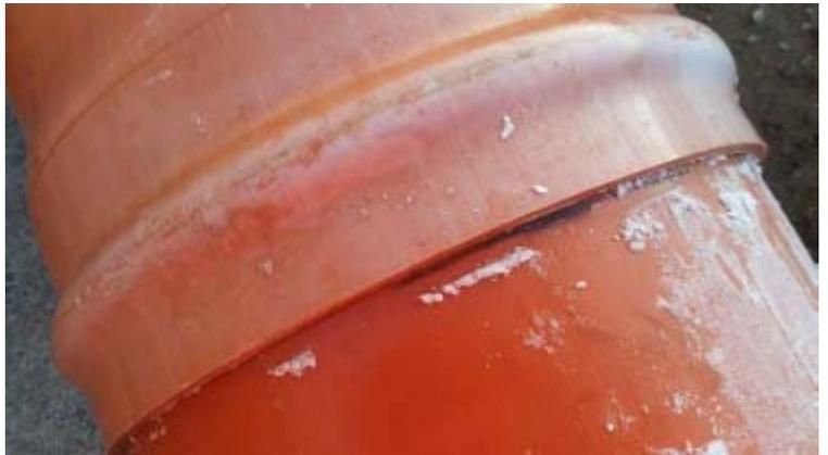
10. Utilizzando una torcia, verificare che la guarnizione non si sia spostata dal bicchiere e il tubo sia ben incastrato fino in fondo.
