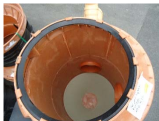
Posa della guarnizione a tenuta stagna sul cono telescopico
