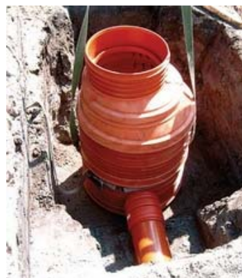
Figura 5 : Posa di una camera da interrare
