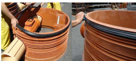
Inserimento della guarnizione a tenuta stagna (foto 4)
