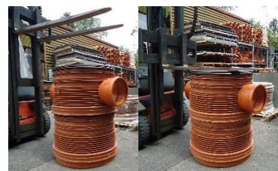
Insertion de la rehausse (point 5)
