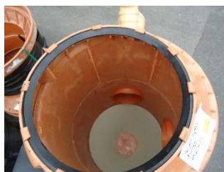
Insertion du joint d'étanchéité sur le cône télescopique
