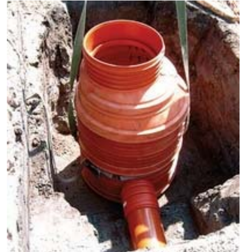
Figure 5 : Pose d'une chambre prête à être remblayée.
