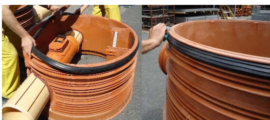
Bild 4 : Gummidichtung wird einglegt
