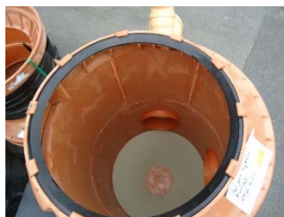
Bild 6 : Gummidichtung auf Teleskop-Konus einlegen
