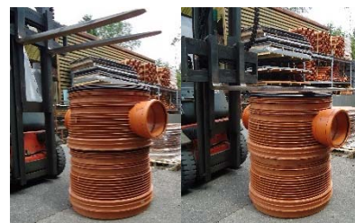
Bild 5 : Schachtrohr wird aufgesetzt
