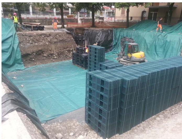
**Figure 11: Mise en place d'un géotextile pour l'infiltration**
