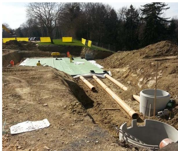
**Figure 6: Connection du réseau pluvial au bassin de rétention**
