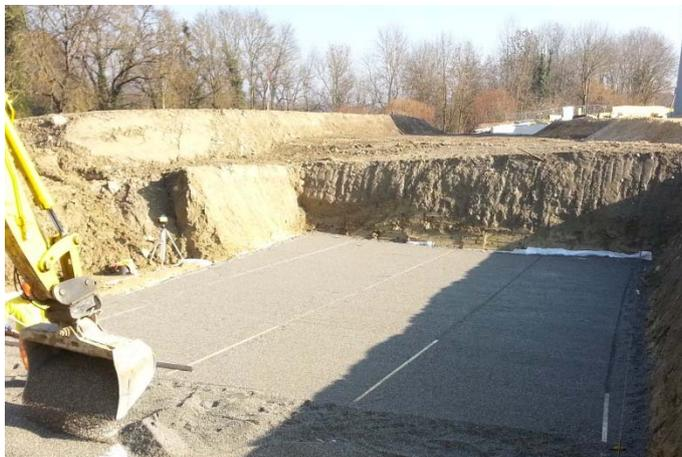
Figure 1: Réalisation du lit de pose
