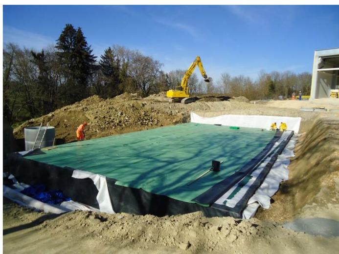
**Figure 7: Mise en place de la géomembrane supérieure**
