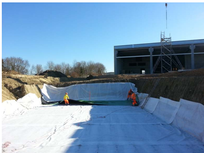
Figure 3 : Mise en place du géotextile extérieur et de la géomembrane
