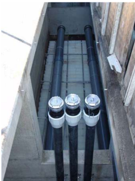
Figure 5 : Vue d'ensemble de la partie supérieure des blocs lamellaires
