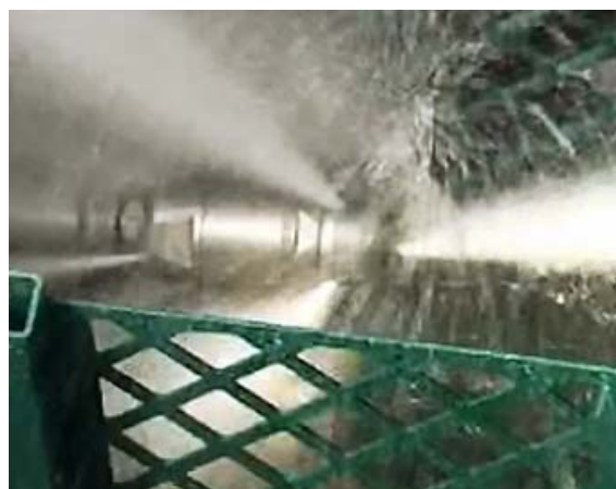
Figure 4 : Hydrocurage à l'intérieur des tunnels d'inspection
