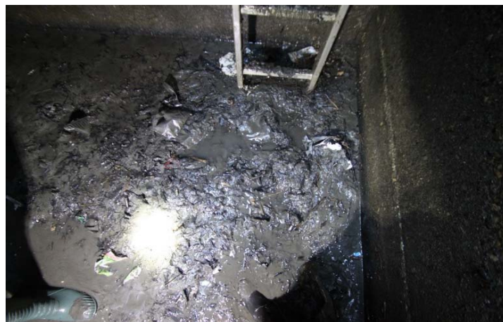
Figure 2 : Polluants piégés dans la chambre de tranquillisation du bassin les Sablons
