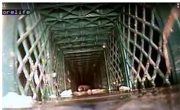
Figure 1 : Inspection avant curage des modules Rigofill® contenant des macrodéchets importants (bassin sale)
