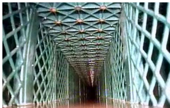
Figure 2 : Inspection après curage (bassin propre)
