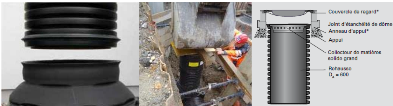
Figure 2: Mise en place des rehausses
