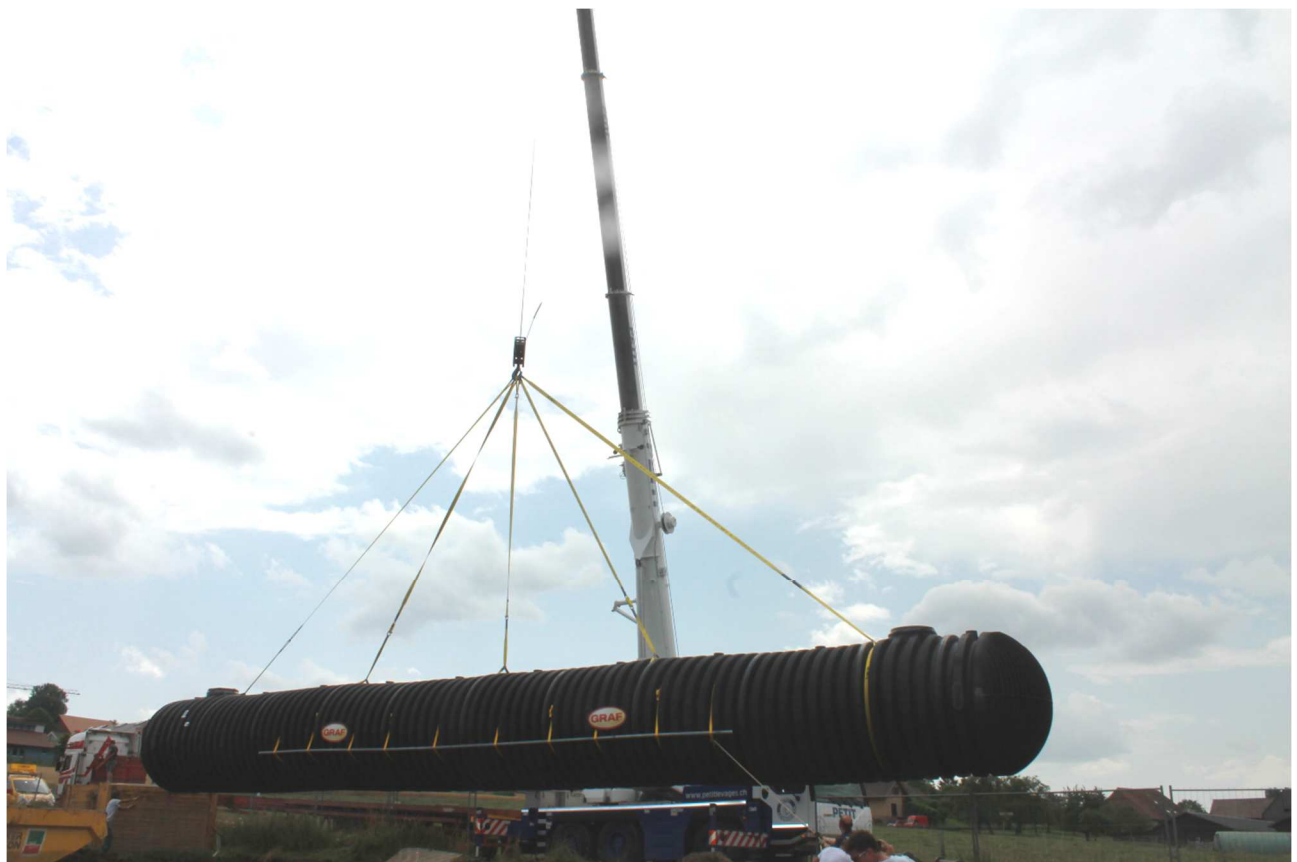
Figure 2 : Cuve de 102'000 litres
