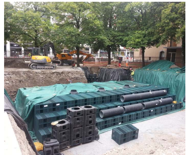
Figure 12 : Mise en place des modules Rigofill® et des chambres Quadro-Control pour réaliser le bassin d'infiltration
