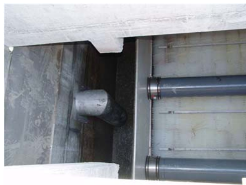
Figure 8 : Siphonide en sortie
