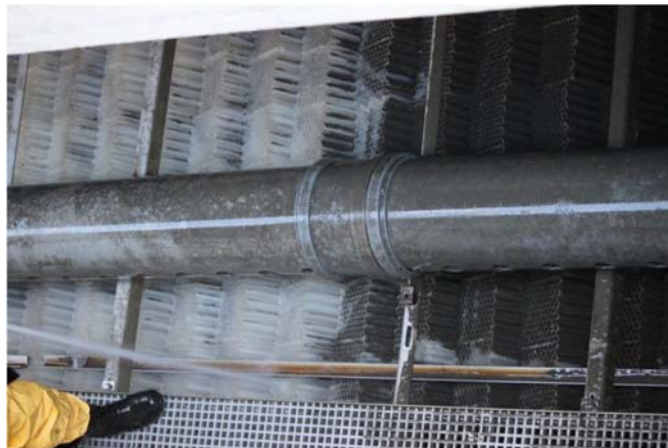
Figure 4 : Lavage des cellules lamellaires nids d'abeilles à l'aide d'une lance à haute pression : à gauche, cellules nettoyées, à droite, cellules non lavées
