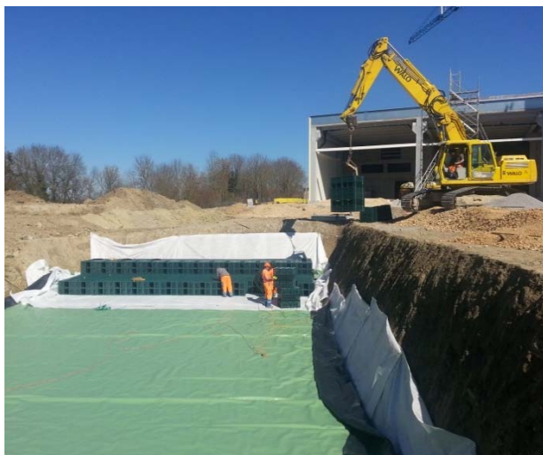
Figure 4 : Mise en place du géotextile intérieur et pose des modules Rigofill®
