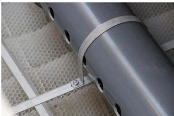
Figure 7 : Goulotte de reprise des eaux décantées
