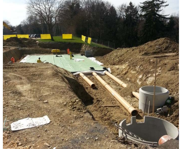
Figure 6 : Connexion du réseau pluvial au bassin de rétention
