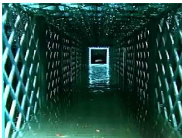
Figure 3 : Inspection d'un bassin type Rigofill® après hydrocurage à travers le passage de curage
