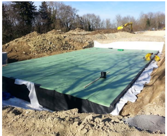
Figure 8 : Réalisation des soudures afin de garantir l'étanchéité totale (en option)
