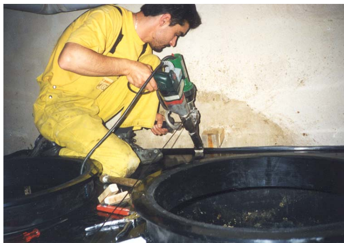
Montage sur place d'un séparateur
