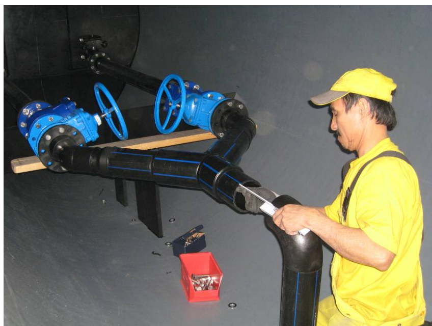
Montage de la sortie de refoulement en PE pression
