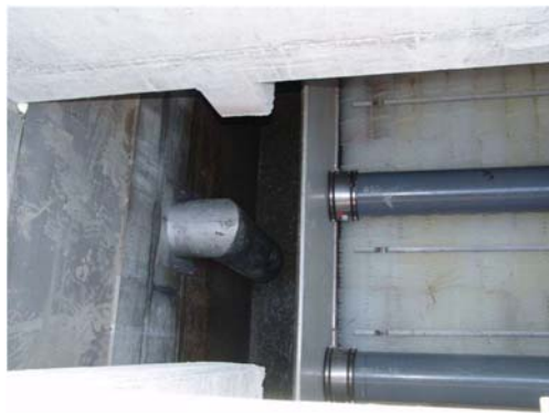
Figure 8 : Siphonide en sortie
