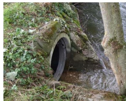
Mise en œuvre d'un clapet anti-refoulement Wastop® Ø 1200 dans une conduite existante en béton permettant d'éviter une mise en charge du réseau lors d'une montée des eaux de la rivière.
