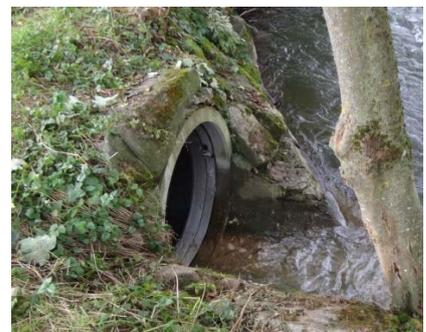
Einbau einer Wastop®-Rückstauklappe Ø 1200 in ein bestehendes Betonrohr, um ein Volllaufen des Rohrleitungsnetzes bei Hochwasser aus dem Fluss zu verhindern.
