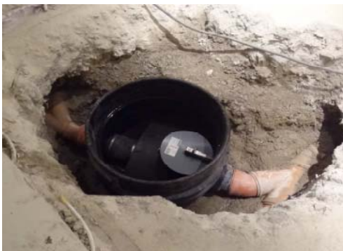
Installation eines Waback ® -Schachts auf ein Abwasser-Kanalssystem
