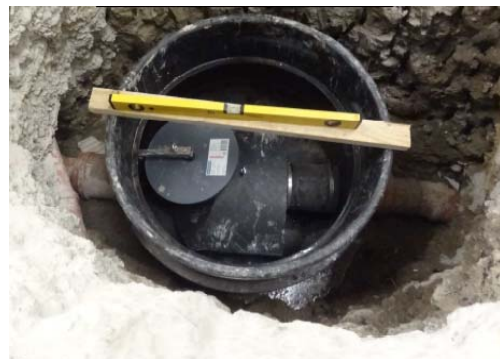
Installation eines Waback ® -Schachts auf ein Abwasser-Kanalssystem
