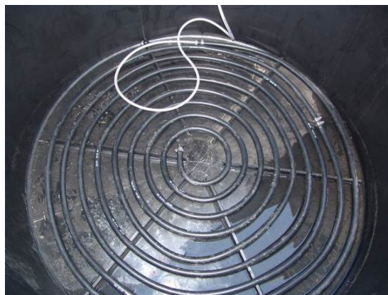
Vue du fond de la fosse avec le flexible 6 mm
