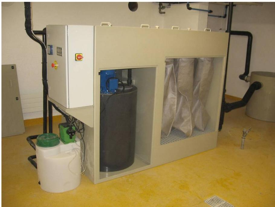
**Cuve de stockage, réacteur de coagulation/floculation, réacteur de contrôle du pH, décanteur lamellaire (procédé Decofloc®)**
