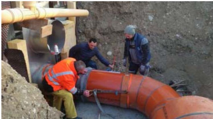
9. Tendre maintenant les 3<sup>ème</sup> et 4<sup>ème</sup> SpanSet simultanément de façon à emboîter le tube jusqu'à la marque faite à l'étape 2. L'emboîtement est maintenant terminé.
