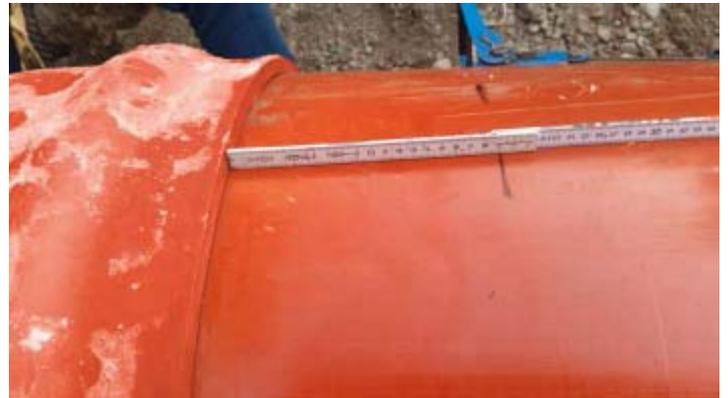
6. Placer le 1<sup>er</sup> SpanSet<sup>®</sup> autour de la gorge du tube et un 2<sup>ème</sup> autour du tube à emboîter, sans les serrer.
