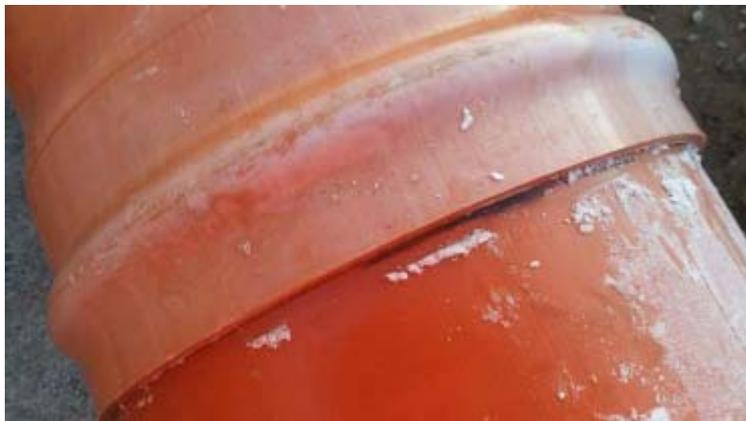
10. Vérifier à l'aide d'une lampe de poche que le joint n'est pas sorti de sa gorge et que le tube est bien emboîté jusqu'au fond. Pour les ventilations de grand diamètre, on peut entrer dans le tube pour effectuer cette vérification.
