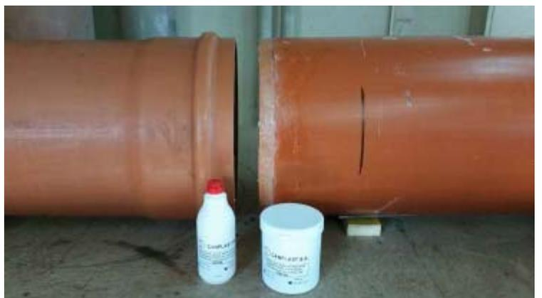
4. Placer les deux tubes à emboîter l'un en face de l'autre. Leurs axes doivent être parfaitement alignés.
