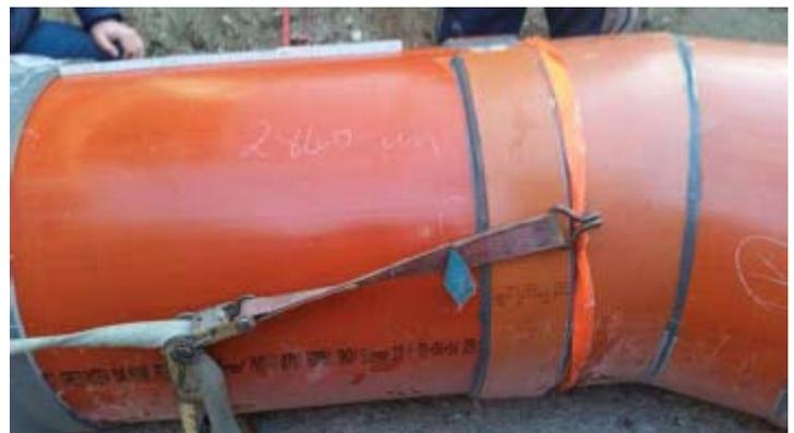
8. Serrer les deux premiers SpanSet® de façon à bien bloquer les 3<sup>ème</sup> et 4<sup>ème</sup> SpanSet® contre les tubes.
