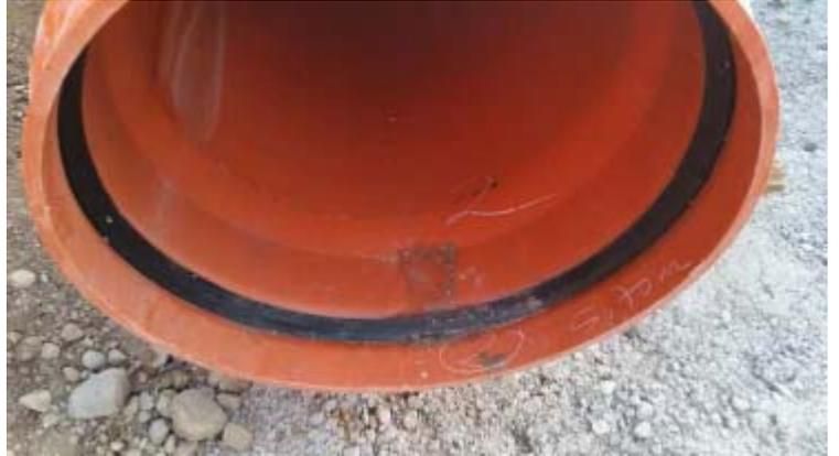
2. Tracer la longueur de l'emboîtement sur l'extrémité lisse du tube à emboîter.
