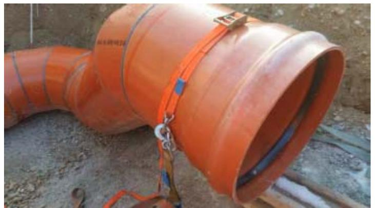
7. Passer un 3<sup>ème</sup> et un 4<sup>ème</sup> SpanSet<sup>®</sup> dans les deux premiers, de chaque côté du tube et le long des axes.
