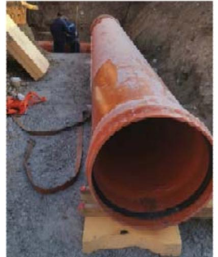
5. Introduire de 2-3 cm le tube dans l'emboîtement en s'arrêtant juste avant le joint.
