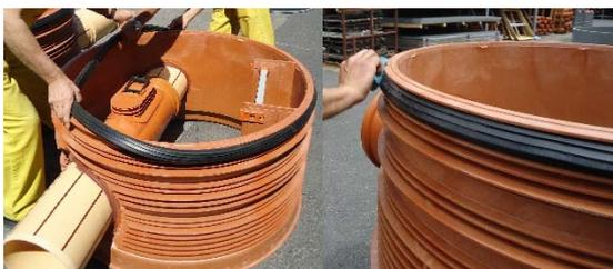
**Insertion du joint d'étanchéité (point 4)**
