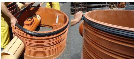
**Insertion du joint d'étanchéité (point 4)**
