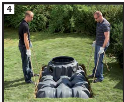
4 Descente de la cuve dans la tranchée à l'aide de sangles (éviter les chocs).
