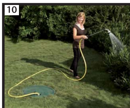
La pose de votre cuve est terminée.
