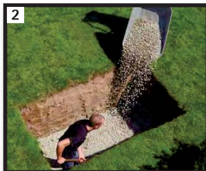
2 Mise en place d'un lit de pose de gravier rond 4/12 d'une épaisseur de 10 à 20 cm dans le fond de l'excavation.
