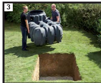
3 Transport de la cuve jusqu'à la fouille.
