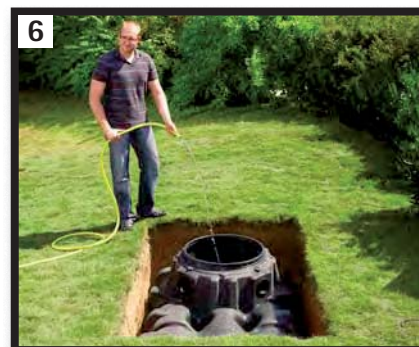
6 Remplissage d'1/3 de la cuve avec de l'eau avant remblai .
