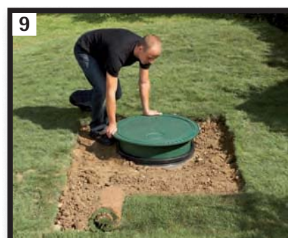
9 Après avoir positionné les accessoires (pompe, filtre), mise en place de la rehausse télescopique et ajustement au niveau du sol. Planter le gazon.
