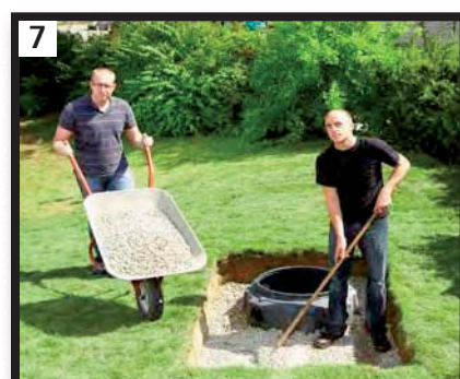
7 Remblai progressif par couches successives de 30 cm de gravier rond 4/12 sur le pourtour de la cuve ainsi que toutes les cavités, jusqu'au recouvrement total du réservoir.
