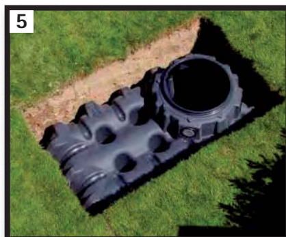
5 Positionnement de la cuve dans la fouille.
