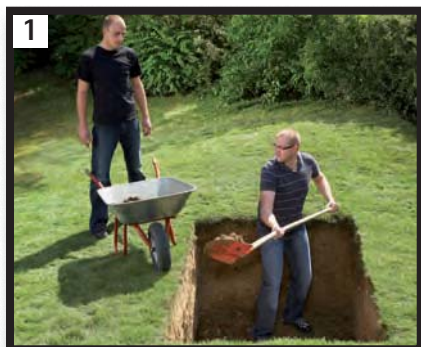
1 Réalisation d'une fouille. Dimensions = cuve +10 cm sur tous les côtés de la cuve.
