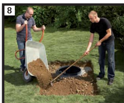
8 Ajustement à la hauteur du terrain par la mise en place de la couche de terre végétale (10 cm minimum).
