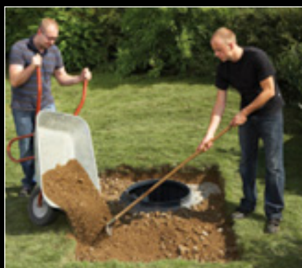
Les photos ci-dessus représentent l'installation d'une cuve Platine® 1500 L.
