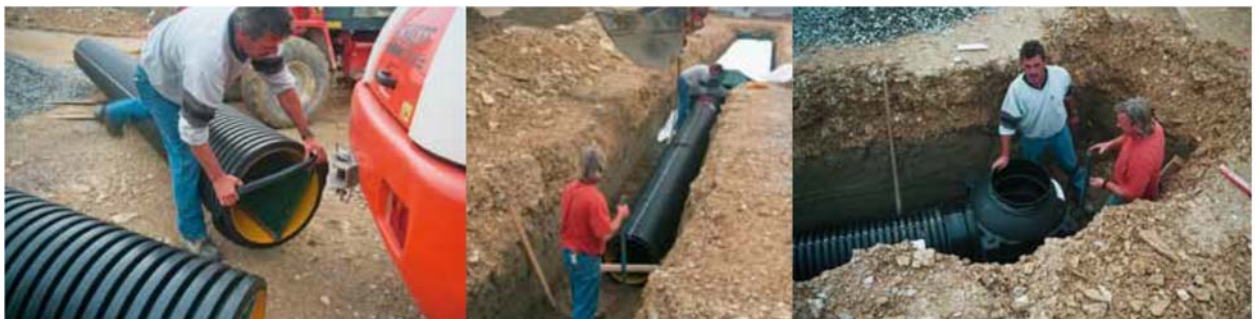
Figure 1: Déroulement des étapes de pose
