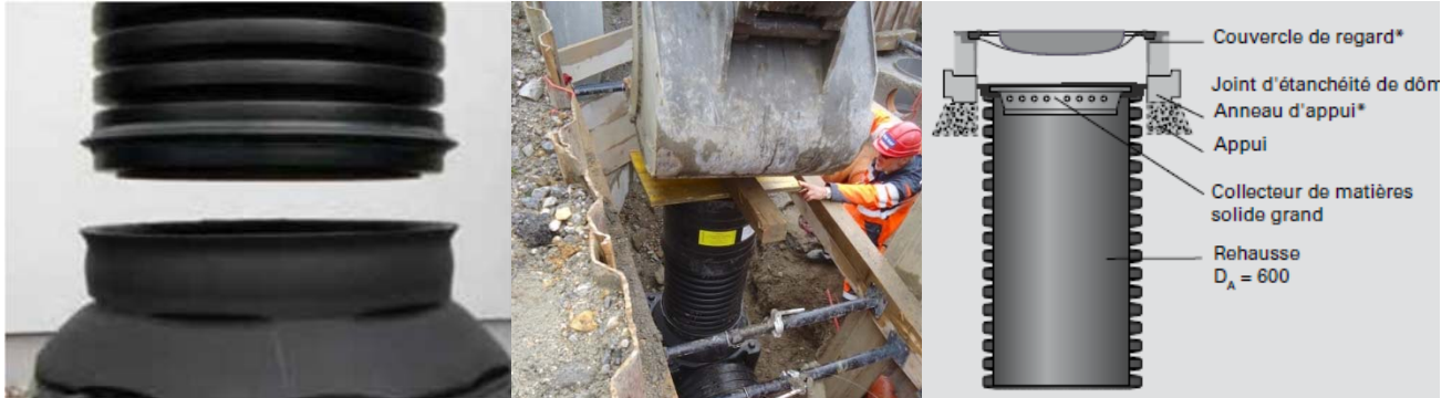
Figure 2: Mise en place des rehausses
