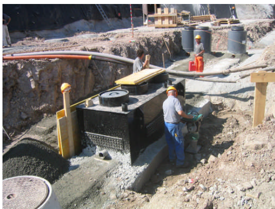
Fettabscheider einbetoniert
