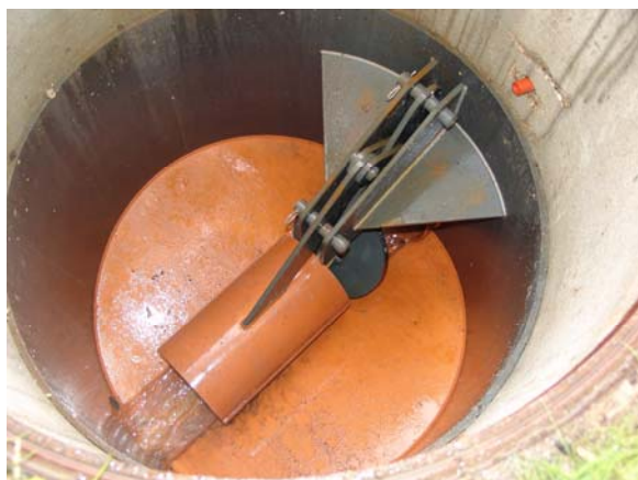
Clapets Ø 200 mm ouvert
