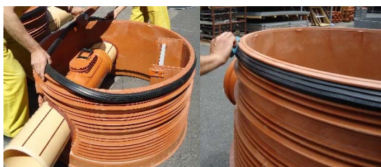
Insertion du joint d'étanchéité (point 4)
