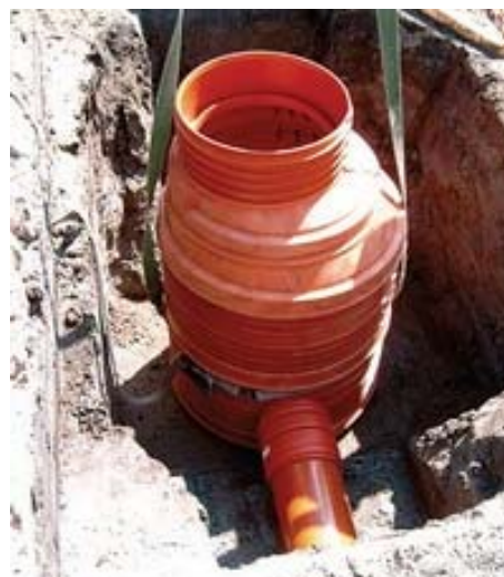
Figure 5 : Pose d'une chambre prête à être remblayée.
